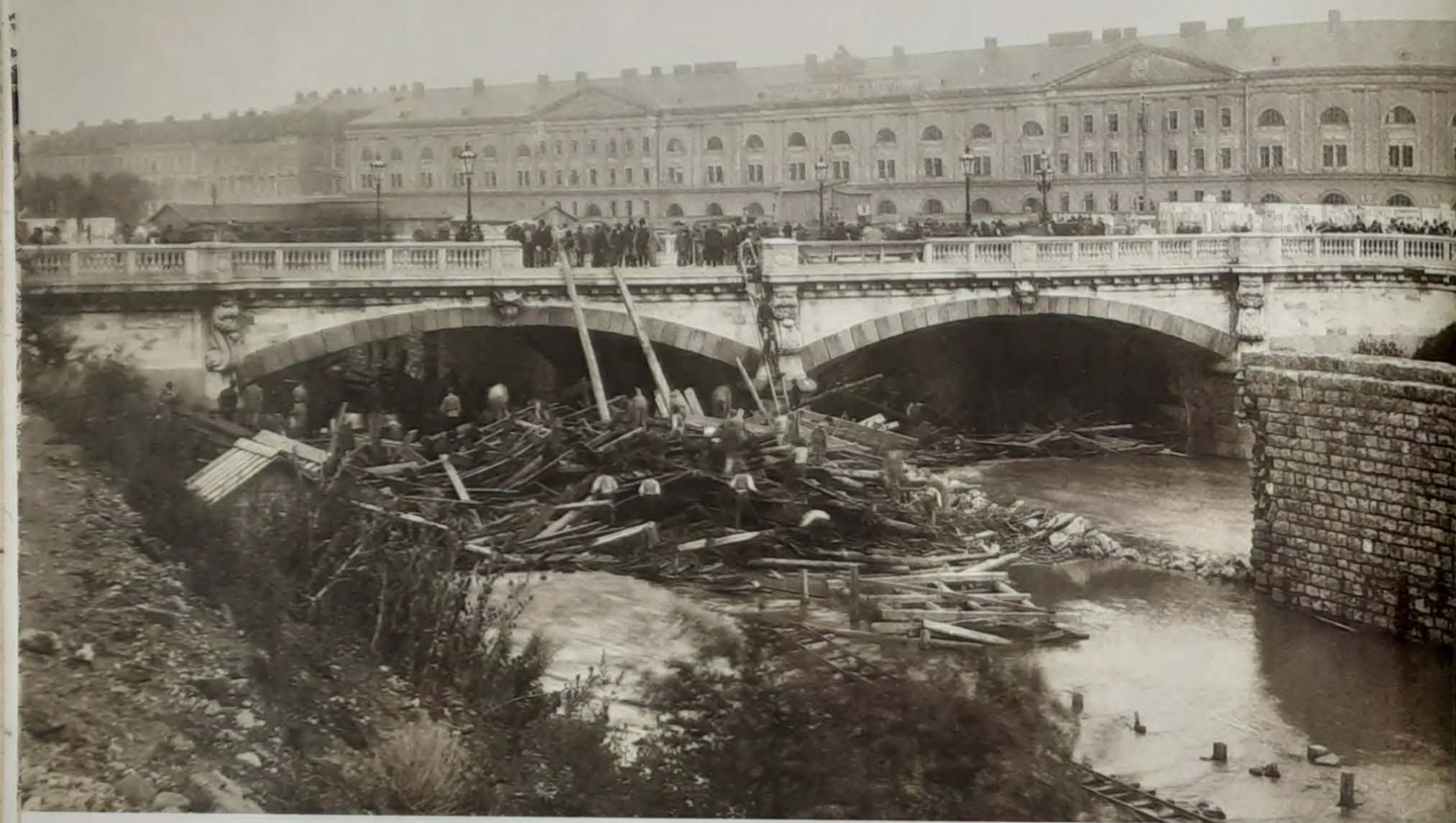
Im Jahr 1897 führte nicht nur die Donau, sondern auch der Wienfluss Hochwasser. Die im Gewässer mitgeführten Holzstämme verklausteten sich an den Brücken, wie diese Abbildung der Schwarzenbergbrücke zeigt. Im Hintergrund ist die Kaiser-Ferdinand-Infanteriekaserne (an der Stelle der späteren Marokkanerkaserne) beim Schwarzenbergplatz zu sehen.
